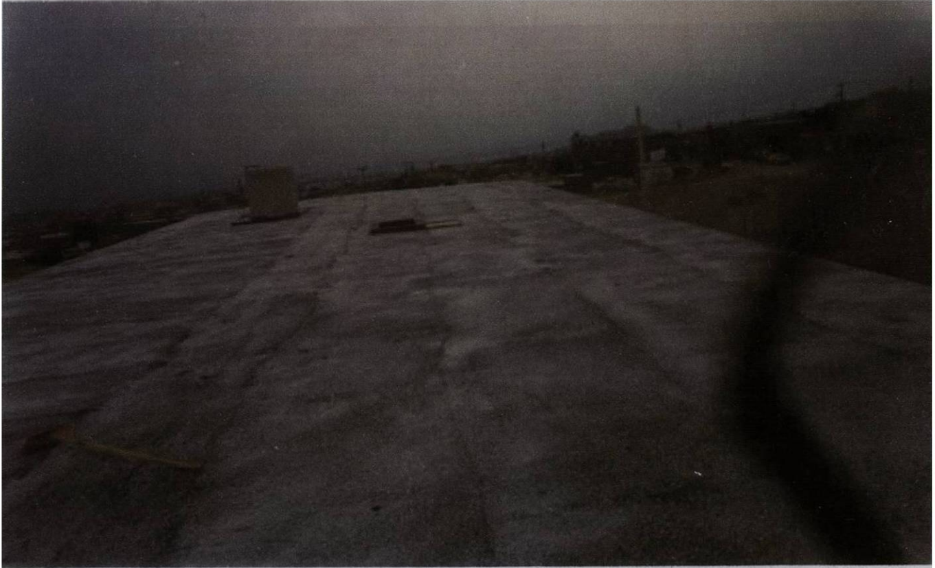
Anexo 13. Aplicación de 3ª capa de emulsión y colocación de Piedra marmol
